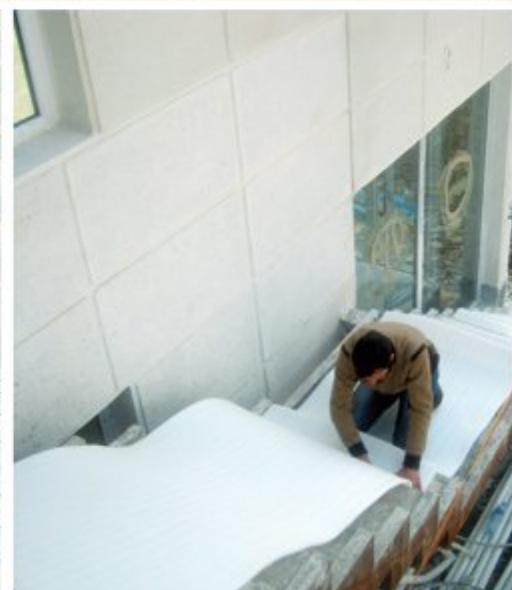
تجهیز کلیه بالکن‌ها، مسیرهای تردد و راه‌پله‌ها به سیستم ذوب برف و یخ الکتریکی هوشمند (اجرا: بهار ۹۰)
