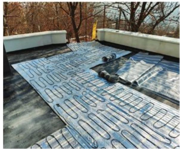
تجهیز سطح بام به سیستم ذوب برف و یخ الکتریکی هوشمند (اجرا ۱۴۰۱)
