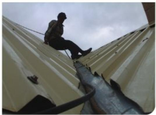
نصب سیستم ذوب برف و یخ الکتریکی بر روی بام و آبراه با هدف ذوب برف و یخ (اجرا: تابستان ۸۷)
