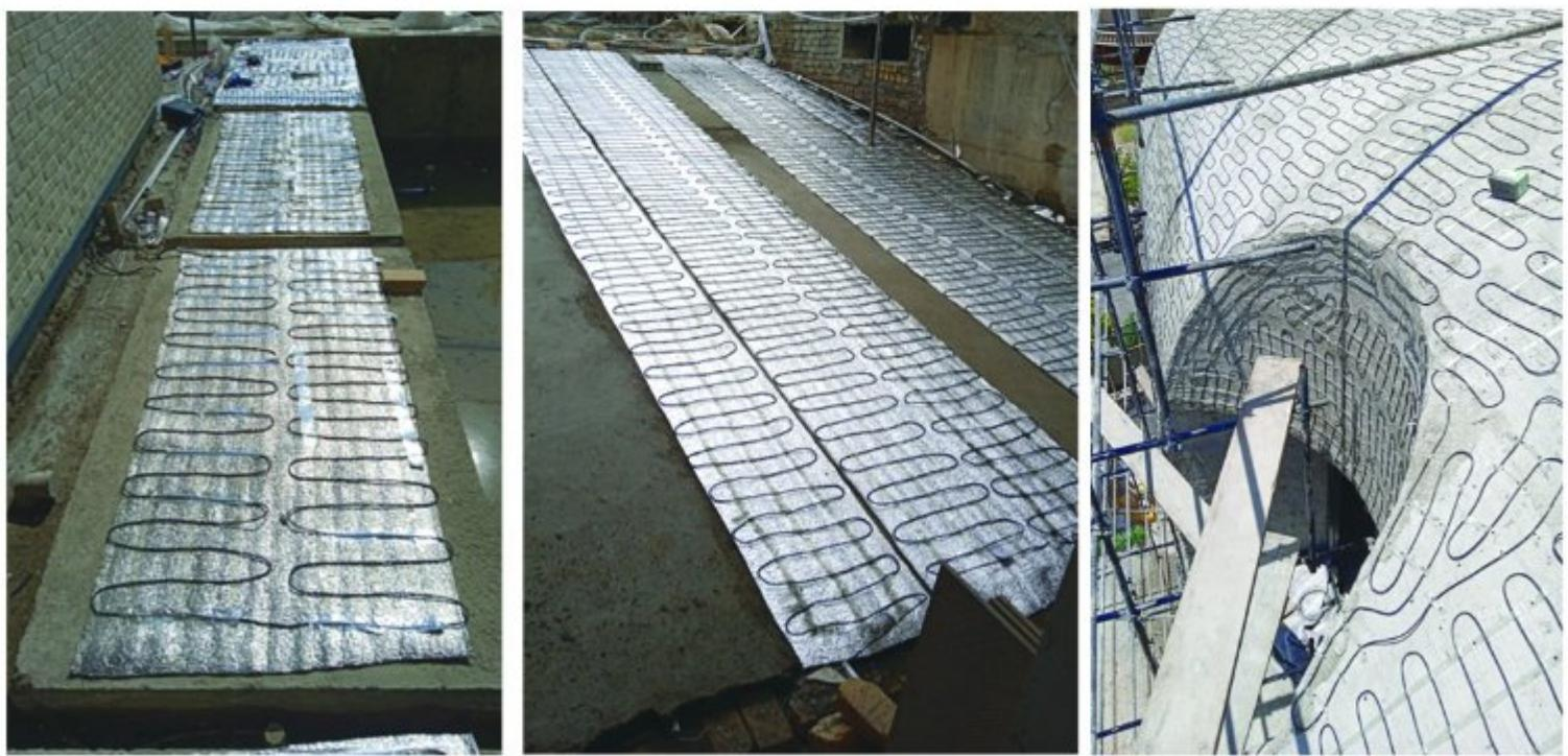
تجهیز سقف ، بدن ساختمان ، مسیر های تردد و رمپ به سیستم ذوب برف الکتریکی هوشمند (اجرا ۱۴۰۱)
