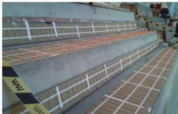
گرمایش از کف سطوح داخلی ساختمان با استفاده از کابل‌های حرارتی
