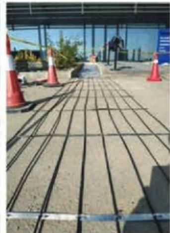
اجرای سیستم ذوب برف و یخ الکتریکی هوشمند در زیر آسفالت
