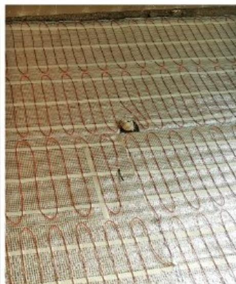
تجهیز سرویس‌های بهداشتی به سیستم گرمایش از کف الکتریکی هوشمند (اجرا: بهار ۹۲)
