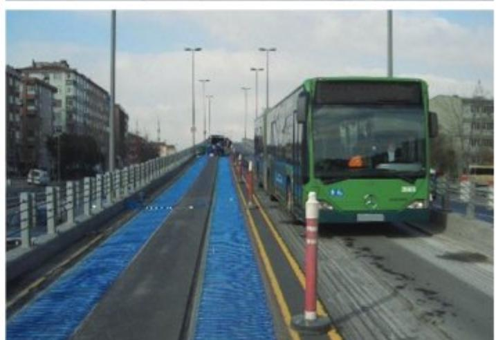
نصب سیستم ذوب برف و یخ الکتریکی در زیر آسفالت
