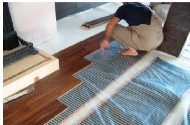
نصب سیستم گرمایش از کف مخصوص پارکت با استفاده از فیلم حرارتی (اجرا: پاییز ۸۹)
