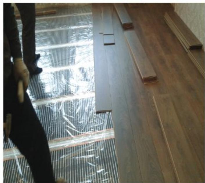
اجرای سیستم گرمایش از کف الکتریکی هوشمند در زیر پارکت ECOFILM (اجرا: بهار ۹۶)
