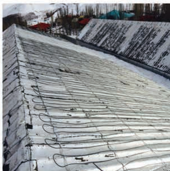
نصب سیستم گرمایشی بر روی بام و مناطق برف گیر جهت جلوگیری از یخ زدگی و انباشت برف (اجرا: زمستان ۹۵)
