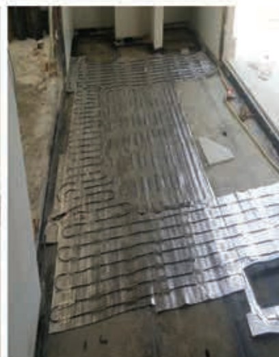
اجرای سیستم گرمایش از کف الکتریکی هوشمند در محوطه اطراف استخر، مسیرهای تردد و سرویس ها
