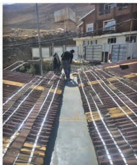
تجهیز بام به سیستم ذوب برف و یخ هوشمند الکتریکی جهت جلوگیری از انباشت برف
