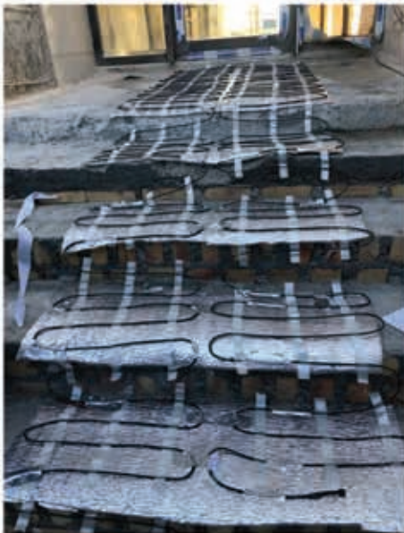
تجهیز رمپ خودرو، مسیرهای تردد و راه پله ها به سیستم ذوب برف و یخ الکتریکی هوشمند
