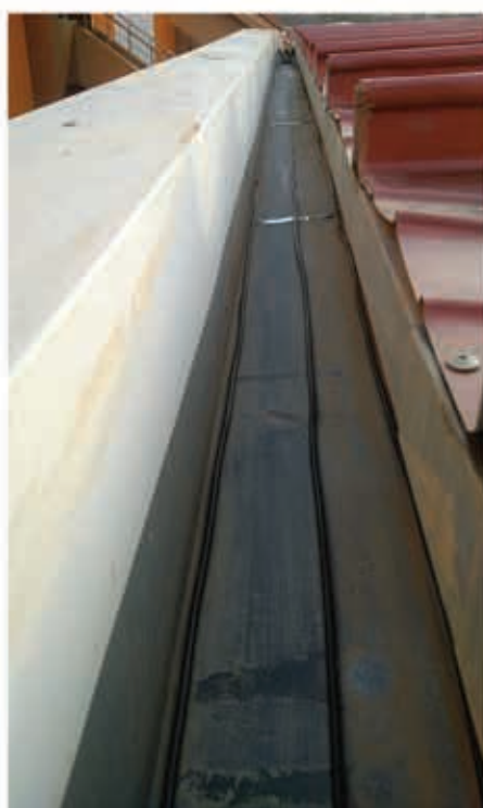
اجرای سیستم ذوب برف و یخ الکتریکی هوشمند آبراه و ناودان
