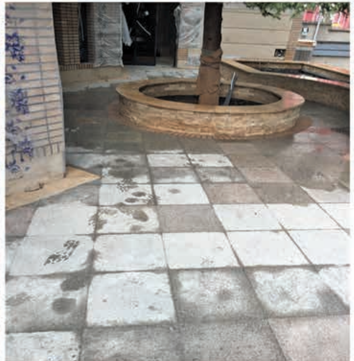
تجهیز مسیرهای تردد به سیستم ذوب برف و یخ الکتریکی (اجرا: پاییز ۹۳)
