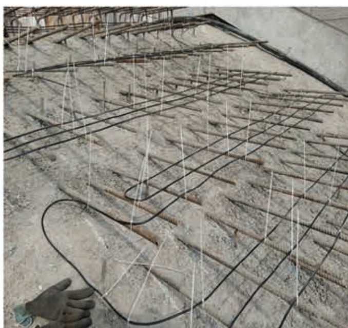
اجرای سیستم ذوب برف و یخ الکتریکی هوشمند در راه پله ها، مسیرهای تردد، رمپ خودرو و تراس
