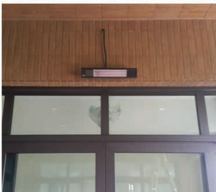
نصب هیترهای تابشی مادون قرمز در بالکن‌ها
