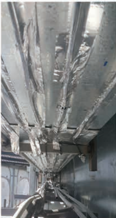
اجرای سیستم ذوب برف و یخ الکتریکی هوشمند آبراه و ناودان
