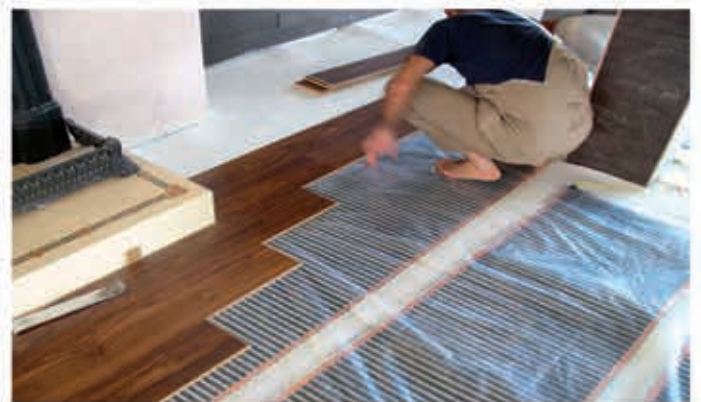
نصب سیستم گرمایش از کف الکتریکی مخصوص پارکت با استفاده از فیلم حرارتی (اجرا: پاییز ۸۹)
