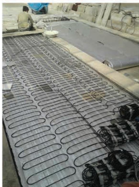
تجهیز مسیرهای تردد و رمپ خودرو به سیستم ذوب برف و یخ هوشمند الکتریکی
