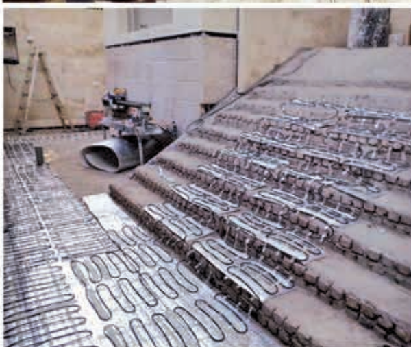
تجهیز راه پله‌ها، رمپ عبور خودرو و مسیرهای تردد به سیستم ذوب برف و یخ الکتریکی هوشمند (اجرا: تابستان ۹۳)
