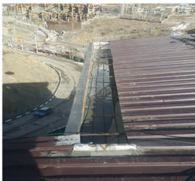
نصب سیستم گرمایشی بر روی بام و مناطق برف گیر جهت جلوگیری از یخ زدگی و انباشت برف
