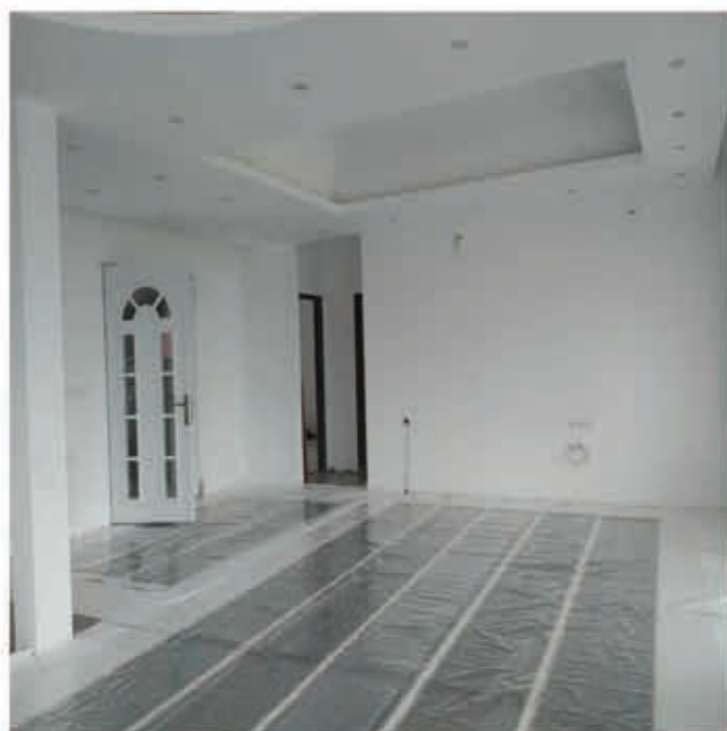
اجرای گرمایش از کف الکتریکی هوشمند با استفاده از فیلم های حرارتی در زیر پارکت
