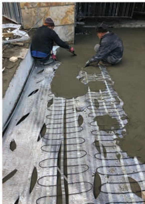
تجهیز مسیرهای تردد و رمپ خودرو به سیستم هوشمند ذوب برف و یخ الکتریکی
