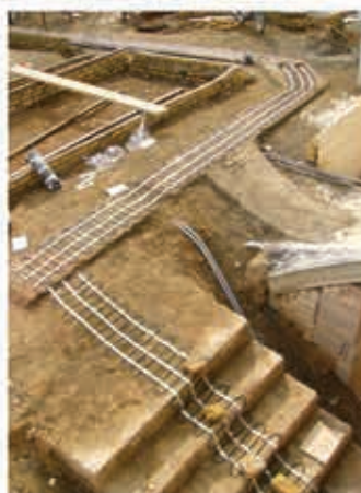
تجهیز محوطه‌های تردد و راه‌پله‌های عبوری به سیستم ذوب برف و یخ الکتریکی هوشمند (اجرا: بهار ۹۱)
