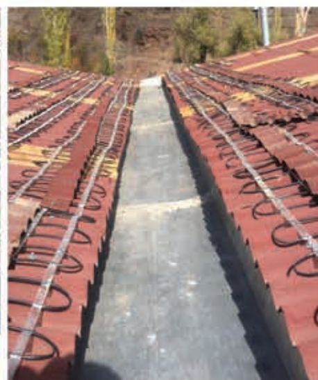
تجهیز بام به سیستم ذوب برف و یخ هوشمند الکتریکی جهت جلوگیری از انباشت برف
