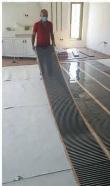
نصب فیلم‌های گرمایشی هوشمند الکتریکی مخصوص پارکت و لمینیت
