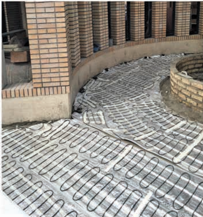
تجهیز مسیرهای تردد به سیستم ذوب برف و یخ الکتریکی (اجرا: پاییز ۹۳)
