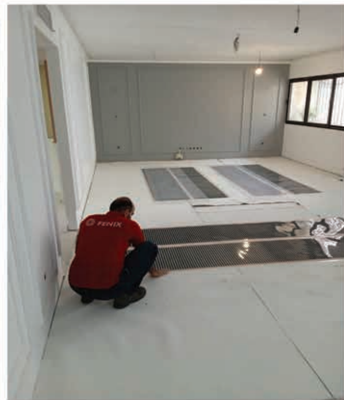
نصب فیلم‌های حرارتی الکتریکی هوشمند مخصوص پارکت و لمینیت در فضاهای نشیمن و اتاق خواب‌ها
