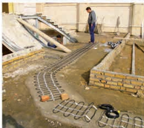
تجهیز محوطه‌های تردد و راه‌پله‌های عبوری به سیستم ذوب برف و یخ الکتریکی هوشمند (اجرا: بهار ۹۱)
