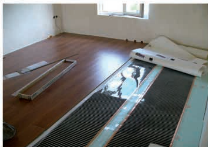
نصب سیستم گرمایش از کف الکتریکی مخصوص پارکت با استفاده از فیلم حرارتی (اجرا: پاییز ۸۹)
