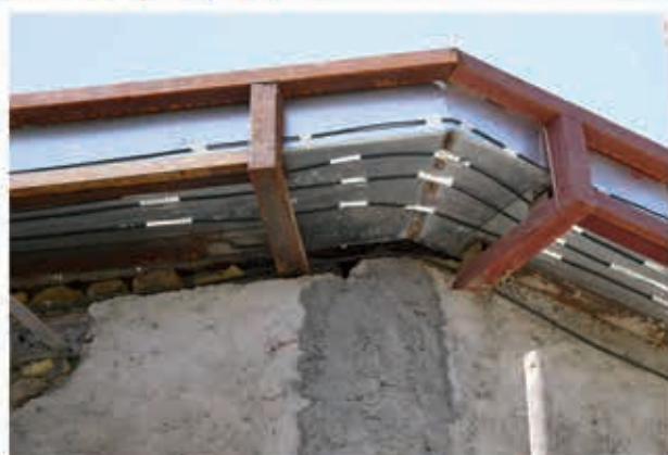
فاز ۱: تجهیز ناودان و آبراه‌ها به سیستم ذوب برف و یخ الکتریکی هوشمند (اجرا: بهار ۹۰)
