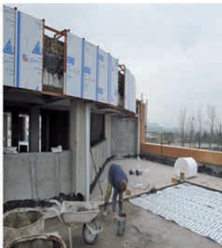
تجهیز پد هلی کوپتر به سیستم هوشمند ذوب برف و یخ الکتریکی (اجرا: بهار ۹۲)
