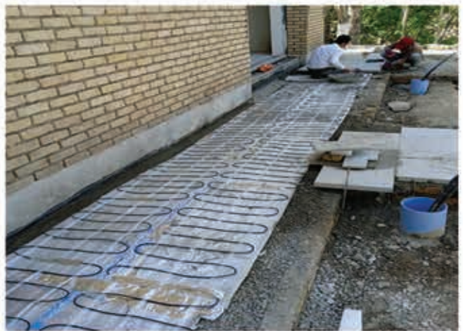
تجهیز مسیر تردد به سیستم هوشمند ذوب برف و یخ الکتریکی
