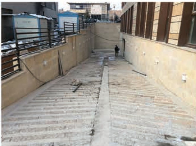
تجهیز رمپ خودرو به سیستم هوشمند ذوب برف و یخ الکتریکی (اجرا: بهار ۹۷)
