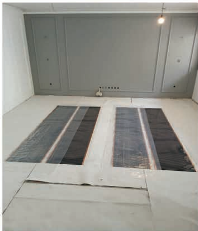
نصب فیلم‌های حرارتی الکتریکی هوشمند مخصوص پارکت و لمینیت در فضاهای نشیمن و اتاق خواب‌ها
