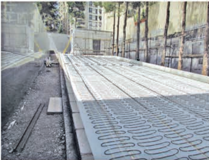
تجهیز رمپ خودرو به سیستم هوشمند ذوب برف و یخ الکتریکی (اجرا: بهار ۹۵)
