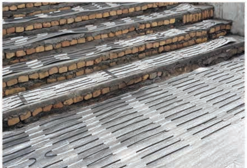
تجهيز مسيرهای تردد و راه پله ها به سيستم ذوب برف و يخ الكتريکی هوشمند
