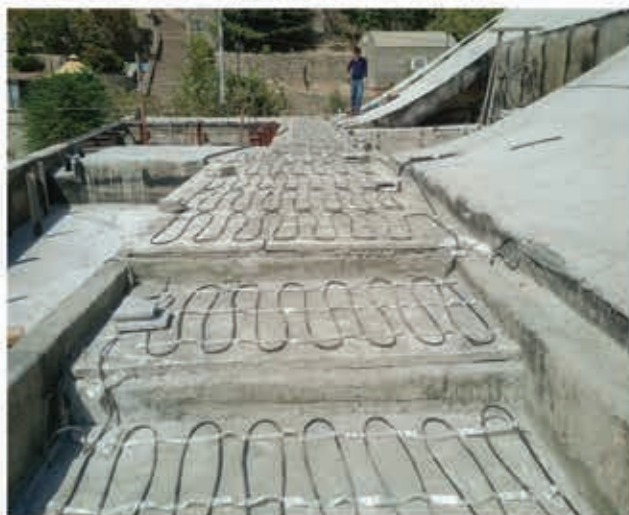
تجهيز رمپ خودر، مسيرهای تردد، راه پله ها و آبراه به سيستم ذوب برف و يخ الكتريكي هوشمند
