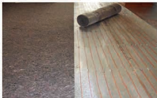
گرمایش از کف مسجد چلبی (استانبول، ساخته شده به سال ۱۴۷۰ میلادی) با استفاده از کابل‌های حرارتی (اجرا: نماینده فنیکس در ترکیه)
