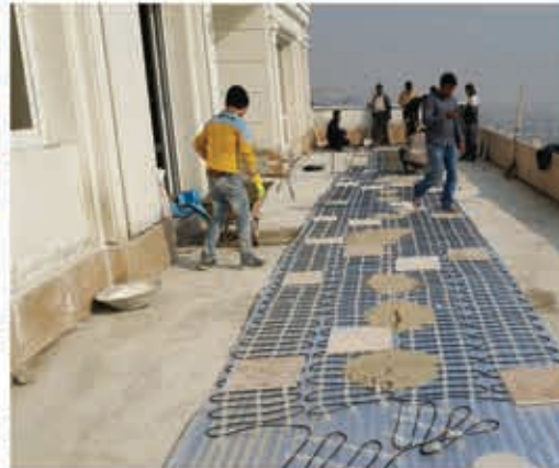
تجهیز محوطه روف گاردن، بالکن های شمالی و جنوبی و رمپ خودرو به سیستم ذوب برف و یخ الکتریکی هوشمند (اجرا: پاییز ۹۳)
