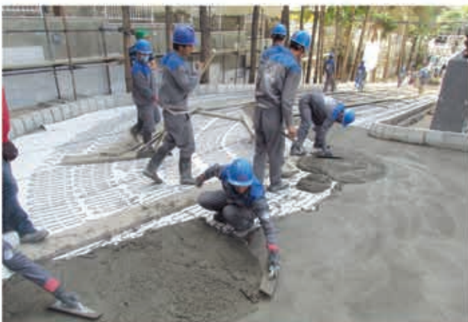
تجهیز رمپ خودرو به سیستم هوشمند ذوب برف و یخ الکتریکی (اجرا: بهار ۹۵)
