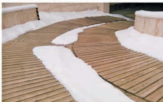
تجهیز رمپ خودرو به سیستم ذوب برف و یخ الکتریکی هوشمند (اجرا: زمستان ۹۰)
