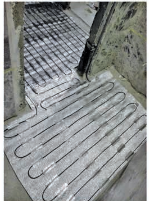
اجرای سیستم گرمایش از کف الکتریکی هوشمند در سرویس های بهداشتی و حمام
