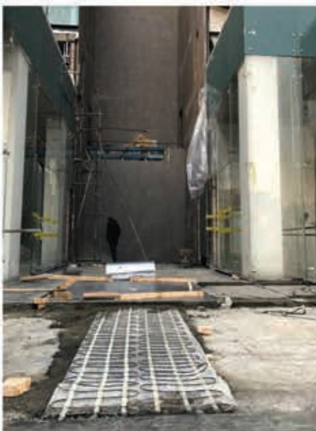
تجهیز رمپ خودرو، مسیرهای تردد و راه‌پله‌ها به سیستم ذوب برف و یخ الکتریکی هوشمند (اجرا: بهار ۹۷)
