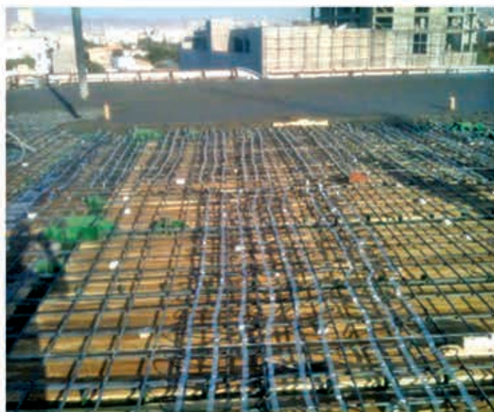
تجهیز پد هلی کوپتر به سیستم ذوب برف و یخ الکتریکی هوشمند (اجرا: بهار ۹۲)
