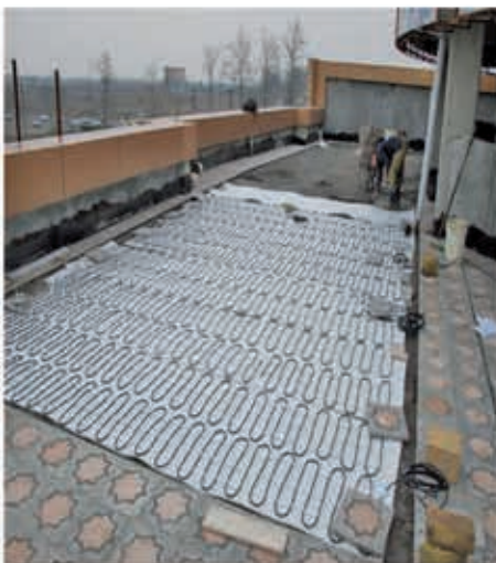
تجهیز پد هلی کوپتر به سیستم هوشمند ذوب برف و یخ الکتریکی (اجرا: بهار ۹۲)
