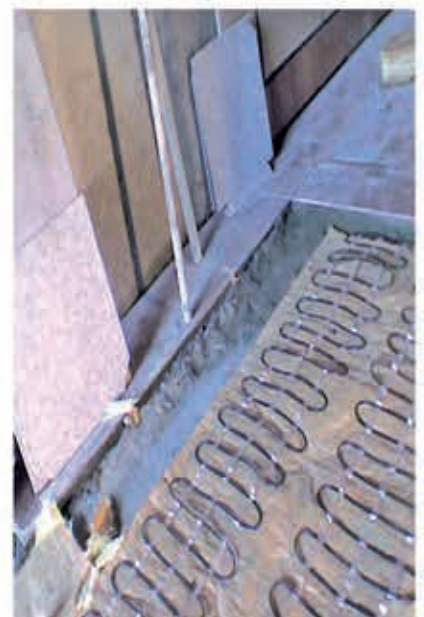
تجهیز مسیرهای ورودی و راهپله‌ها به سیستم ذوب برف و یخ الکتریکی هوشمند (اجرا: زمستان ۸۹)
