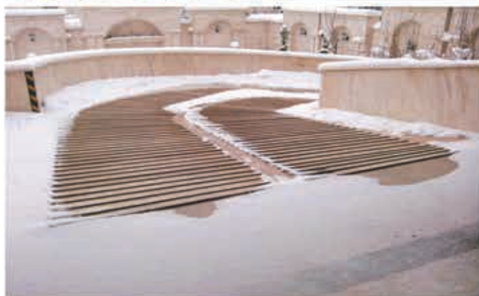
تجهیز رمپ خودرو به سیستم ذوب برف و یخ الکتریکی هوشمند (اجرا: زمستان ۹۰)
