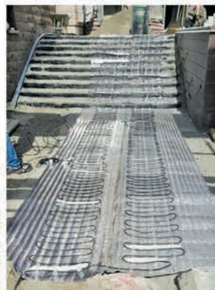
تجهیز مسیرهای تردد، راه‌پله‌ها و رمپ خودرو به سیستم هوشمند ذوب برف و یخ الکتریکی (اجرا: تابستان ۹۴)
