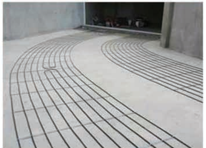
تجهیز رمپ خودرو به سیستم ذوب برف و یخ الکتریکی هوشمند (اجرا: بهار ۹۲)
