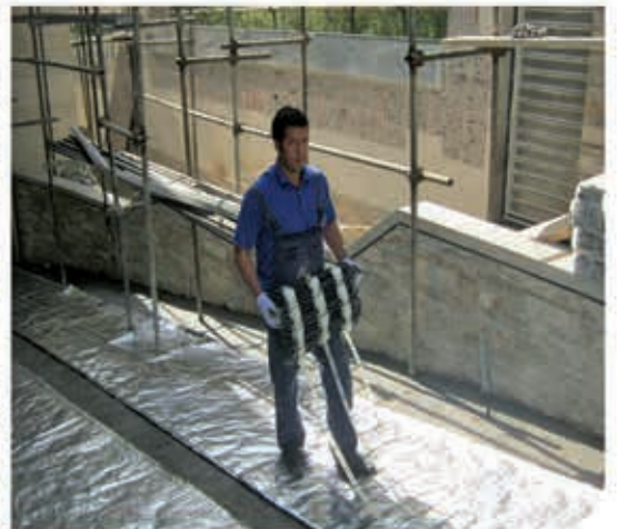
تجهیز مسیر تردد، راه‌پله‌های ورودی و رمپ خودرو به سیستم الکتریکی ذوب برف و یخ هوشمند (اجرا: بهار ۹۰)
