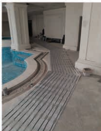
اجرای سیستم گرمایش از کف الکتریکی هوشمند در محوطه اطراف استخر، مسیرهای تردد و سرویس ها
