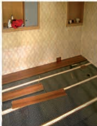
نصب سیستم گرمایش از کف الکتریکی مخصوص پارکت با استفاده از فیلم حرارتی بدون نیاز به تخریب، مناسب برای بازسازی (اجرا: زمستان ۹۱)
