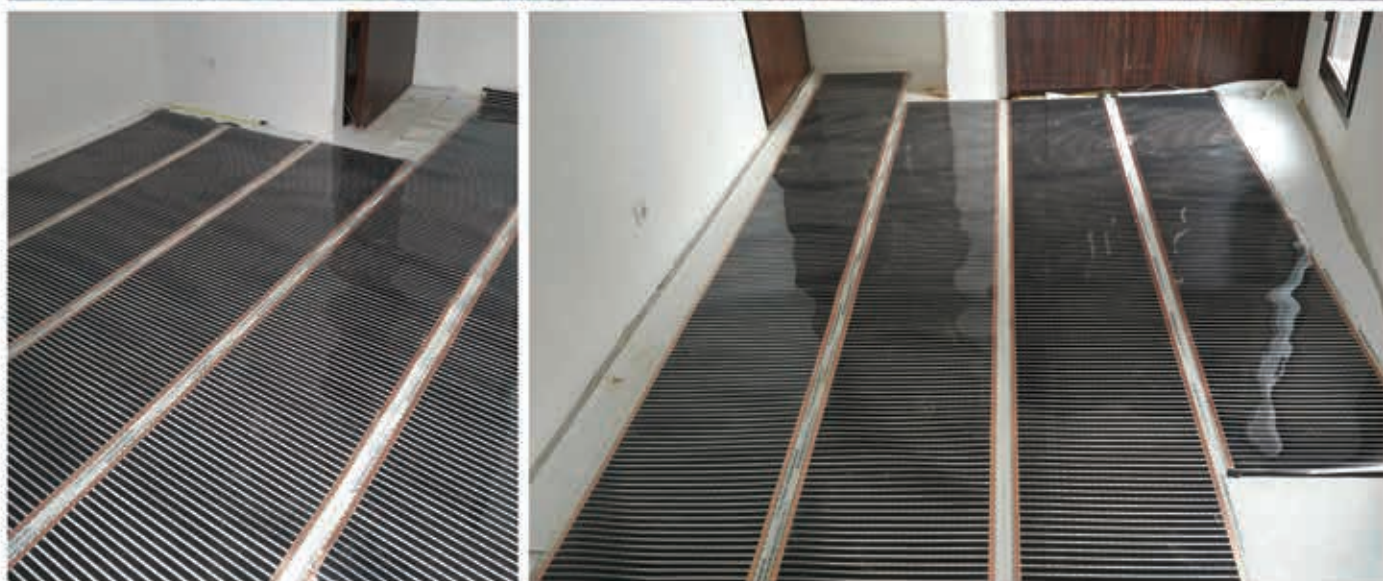
نصب فیلم‌های حرارتی هوشمند الکتریکی مخصوص پارکت و لمینیت در اتاق خواب ها (Ecofilm) (اجرا: بهار ۹۷)
