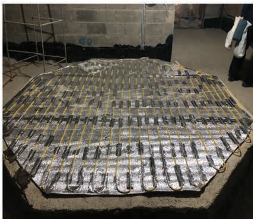
اجراى سيستم گرمايش از كف الكتريكى هوشمند در محوطه حمام تركى
