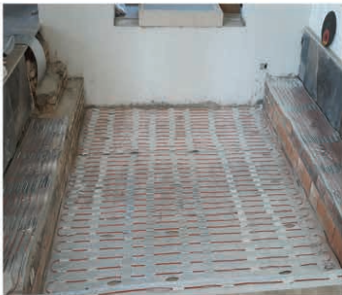
نصب سیستم گرمایش از کف الکتریکی هوشمند در سرویس ها، نشیمن و اتاق ها
