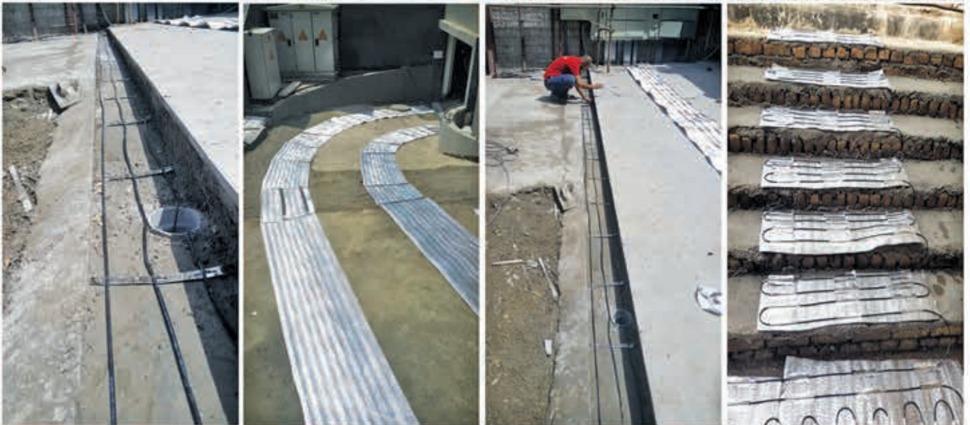
تجهیز کلیه بالکن‌ها، رمپ خودرو، آبراه (گاتر)، مسیر تردد و پله‌ها به سیستم ذوب برف و یخ الکتریکی تجهیز هوشمند. (اجرا: تابستان ۹۳)
