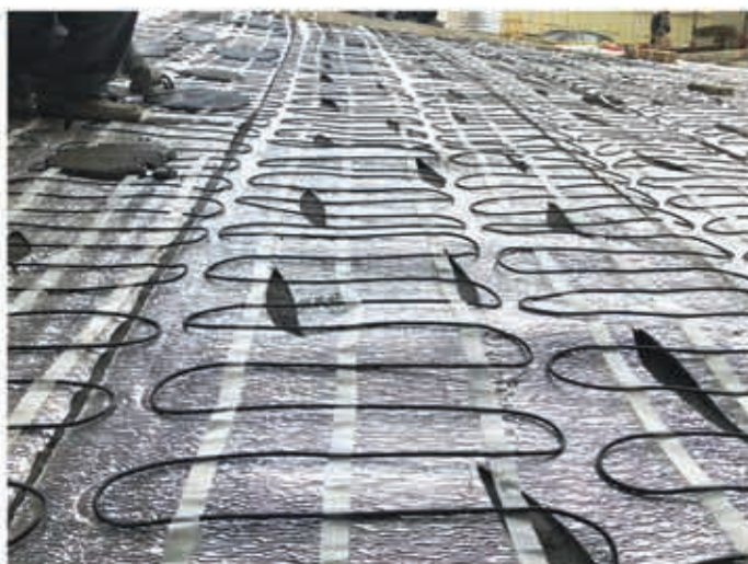
تجهیز مسیرهای تردد و رمپ خودرو به سیستم هوشمند ذوب برف و یخ الکتریکی
