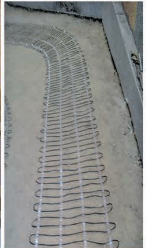
تجهیز رمپ خودرو به سیستم ذوب برف و یخ الکتریکی (اجرا: پاییز ۸۷)
