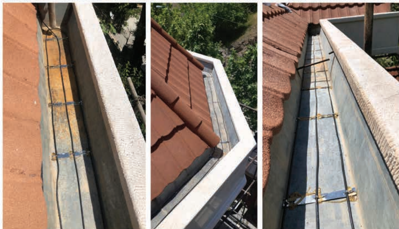
تجهیز سکوهای آلاچیق به سیستم گرمایش از کف الکتریکی هوشمند (اجرا: بهار ۹۰)
