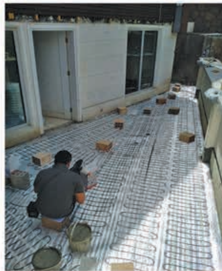
- تجهیز محوطه بالکن‌ها به سیستم هوشمند ذوب برف و یخ الکتریکی - استفاده از کابل حرارتی داخل آبراه با هدف ذوب برف و یخ (اجرا: بهار ۹۷)
