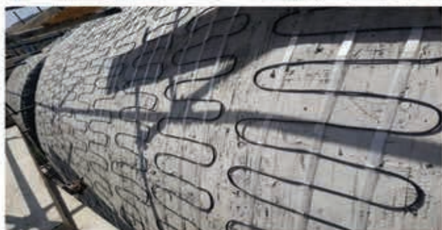
تجهيز بام به سيستم ذوب برف الكتريكي هوشمند به وسيله كابل هاي حرارتي
