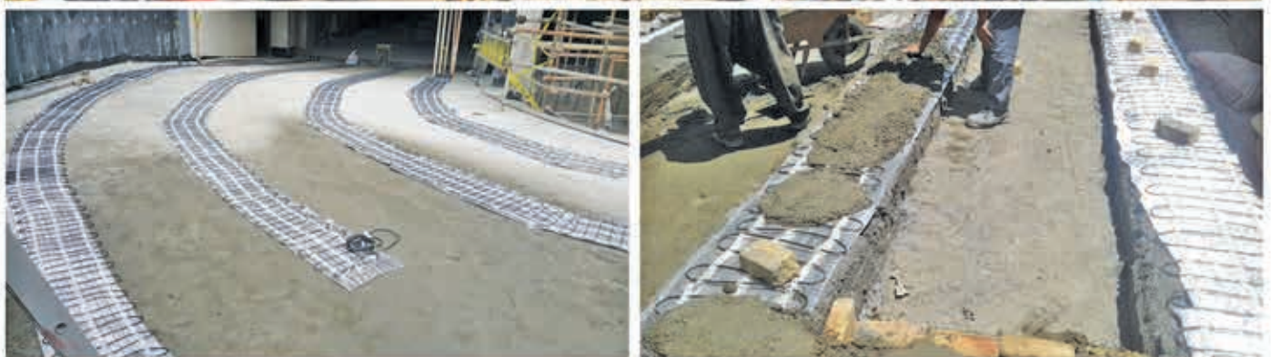
تجهیز رمپ خودرو به سیستم هوشمند ذوب برف و یخ الکتریکی (اجرا: پاییز ۹۵)
