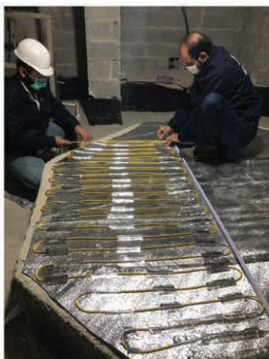
اجراى سيستم گرمايش از كف الكتريكى هوشمند در محوطه حمام تركى
