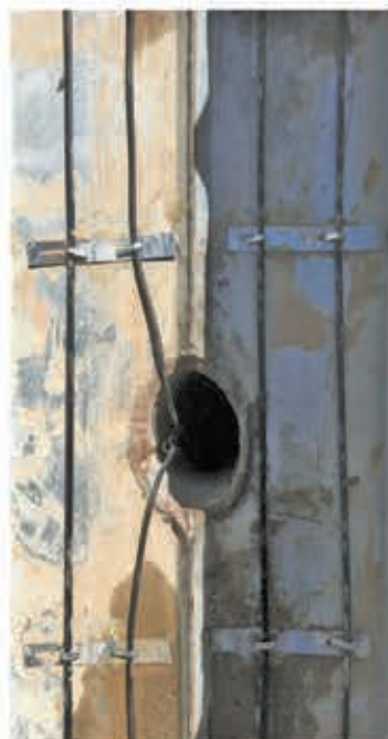
نصب سیستم جلوگیری از یخ زدگی با استفاده از کابل های حرارتی به همراه سیستم کنترل و فرمان هوشمند (اجرا: پائیز و زمستان ۹۶)
