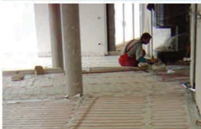
تجهیز محوطه اطراف استخر، اتاق‌ها و به سیستم گرمایش از کف الکتریکی هوشمند (اجرا: بهار ۹۷)
