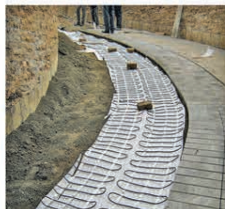
تجهیز رمپ خودرو به سیستم ذوب برف و یخ الکتریکی هوشمند (اجرا: بهار ۹۳)
