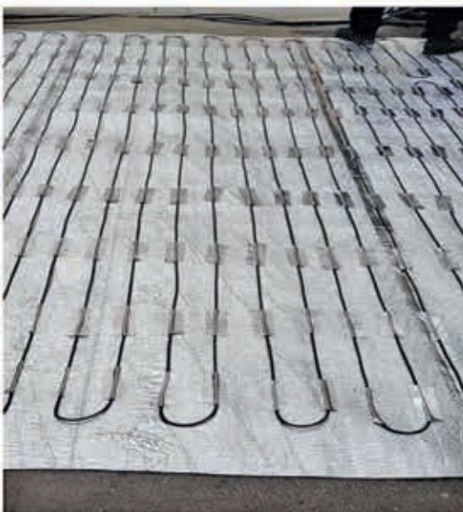
تجهيز مسيرهای تردد و راه پله ها به سيستم ذوب برف و يخ الكتريکی هوشمند
