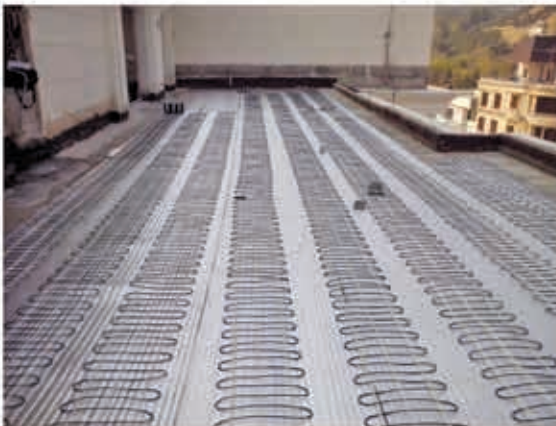
تجهیز محوطه روف گاردن، بالکن های شمالی و جنوبی و رمپ خودرو به سیستم ذوب برف و یخ الکتریکی هوشمند (اجرا: پاییز ۹۳)
