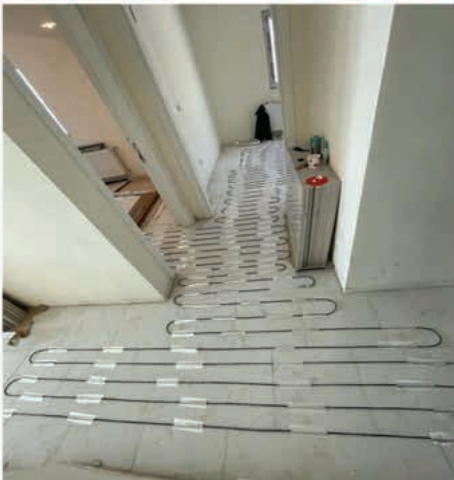
تجهیز سطوح داخلی ساختمان به سیستم گرمایش از کف الکتریکی هوشمند
