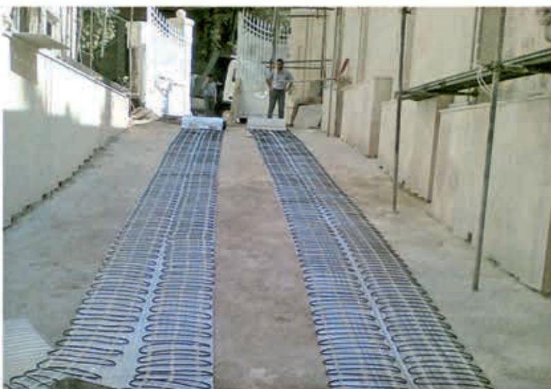
تجهیز رمپ خودرو به سیستم ذوب برف و یخ الکتریکی هوشمند (اجرا: پاییز ۹۳)
