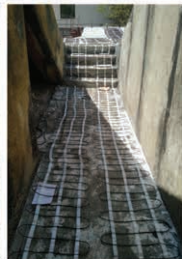
تجهيز رمپ خودر، مسيرهای تردد، راه پله ها و آبراه به سيستم ذوب برف و يخ الكتريكي هوشمند
