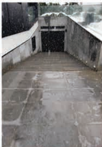
تجهيز رمپ خودر، مسيرهای تردد، راه پله ها و آبراه به سيستم ذوب برف و يخ الكتريكي هوشمند
