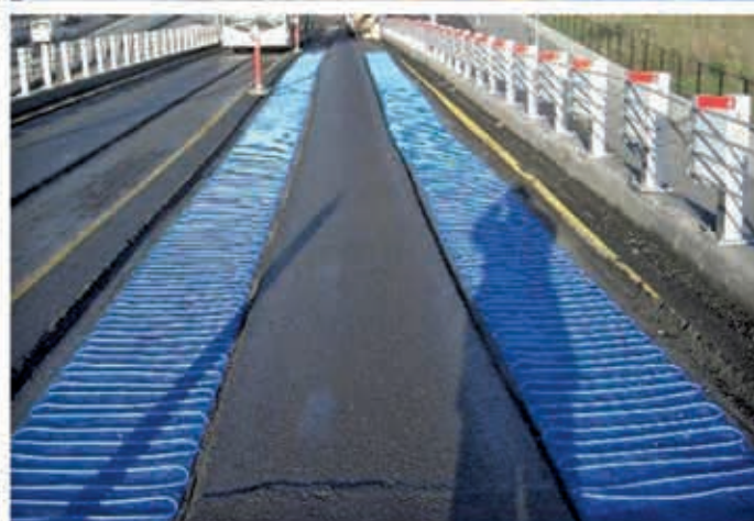
نصب سیستم ذوب برف و یخ الکتریکی در زیر آسفالت جهت جلوگیری از یخ زدگی مسیر تردد اتوبوس
