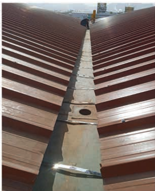
تجهیز ناودان و آبراه سوله های صنعتی به سیستم ذوب برف و یخ الکتریکی هوشمند
