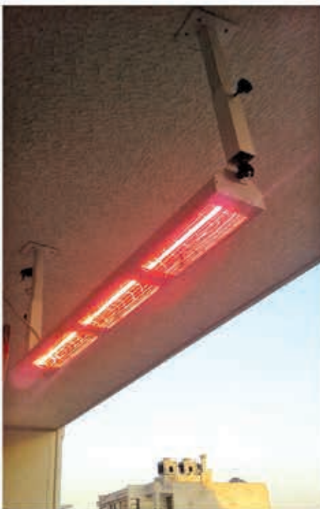
نصب هیترهای تابشی (Burda) در محوطه بالکن جهت استفاده در فصول سرد (اجرا: زمستان ۹۶)
