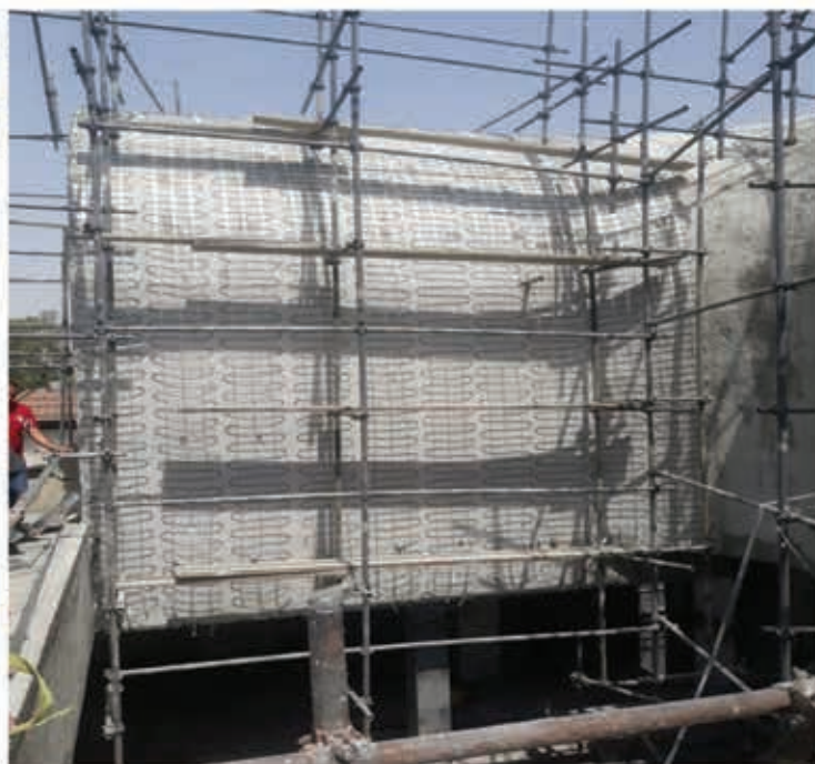
تجهيز بام به سيستم ذوب برف الكتريكي هوشمند به وسيله كابل هاي حرارتي
