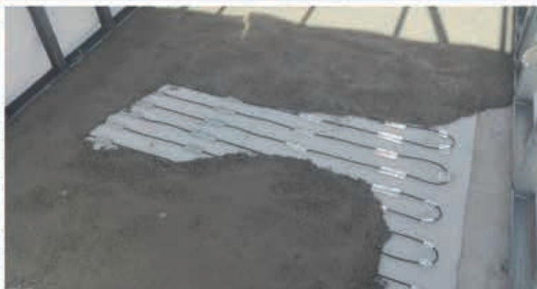
سیستم گرمایش از کف الکتریکی (ویلاهای LSF)
