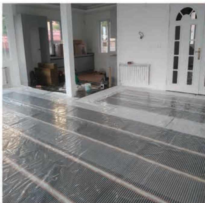
اجرای گرمایش از کف الکتریکی هوشمند با استفاده از فیلم های حرارتی در زیر پارکت
