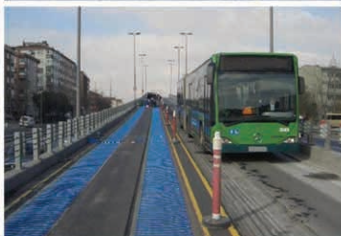
نصب سیستم ذوب برف و یخ الکتریکی در زیر آسفالت جهت جلوگیری از یخ زدگی مسیر تردد اتوبوس
