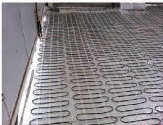
تجهیز رمپ عبور خودرو درب پارکینگ (بست حر عاملی) به سیستم گرمایش از کف الکتریکی هوشمند (اجرا: بهار ۹۳)
