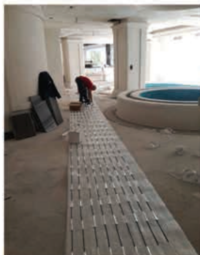
اجرای سیستم گرمایش از کف الکتریکی هوشمند در محوطه اطراف استخر، مسیرهای تردد و سرویس ها
