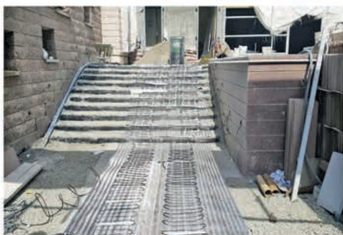
تجهیز مسیرهای تردد، راه‌پله‌ها و رمپ خودرو به سیستم هوشمند ذوب برف و یخ الکتریکی (اجرا: تابستان ۹۴)
