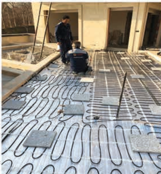
تجهيز محوطه بالکن به سيستم هوشمند ذوب برف و يخ الکتریکی (اجرا: زمستان ۹۶)
