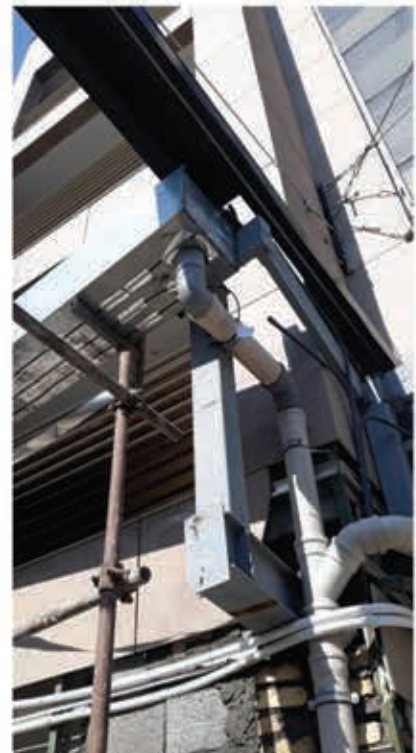
اجرای سیستم ذوب برف و یخ الکتریکی هوشمند آبراه و ناودان
