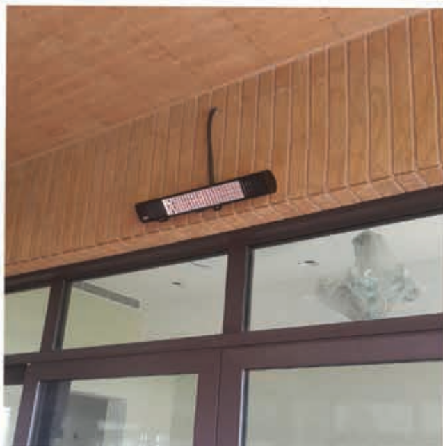
نصب هیترهای تابشی مادون قرمز در بالکن‌ها
