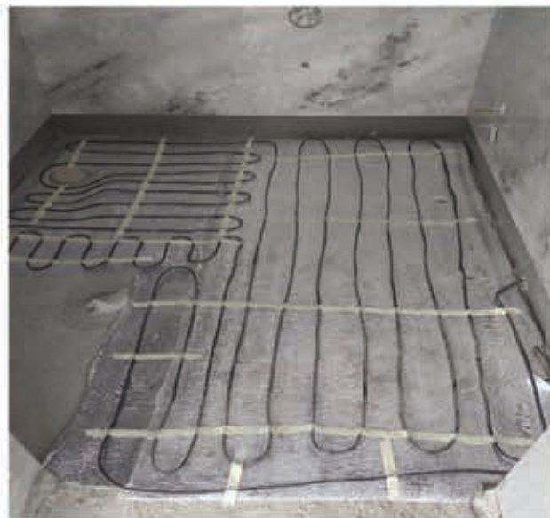
نصب سیستم گرمایش از کف الکتریکی هوشمند در سرویس های بهداشتی
