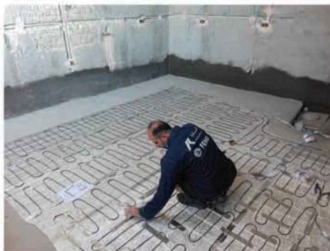
اجرای سیستم گرمایش از کف الکتریکی هوشمند در زیر سرامیک
