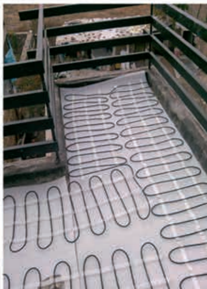
تجهیز کلیه بالکن‌ها، مسیرهای تردد و راه‌پله‌ها به سیستم ذوب برف و یخ الکتریکی هوشمند (اجرا: بهار ۹۰)
