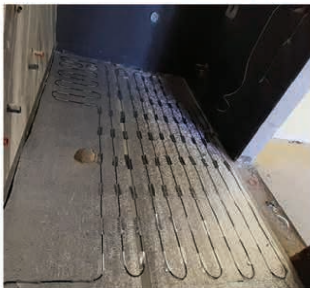
نصب سیستم گرمایش از کف الکتریکی هوشمند در سرویس های بهداشتی
