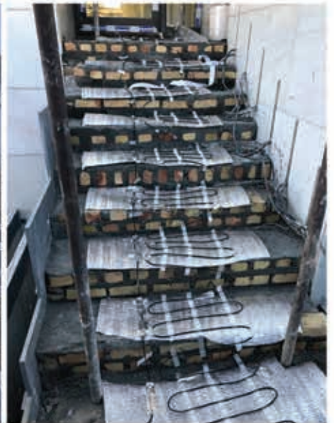
تجهیز رمپ خودرو، مسیرهای تردد و راه پله ها به سیستم ذوب برف و یخ الکتریکی هوشمند
