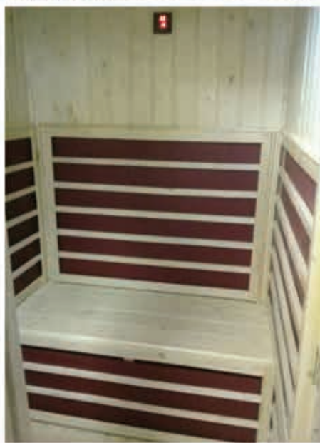
تجهیز بخشی از حمام به سونای خشک مادون قرمز با استفاده از هیترهای تابشی IR
