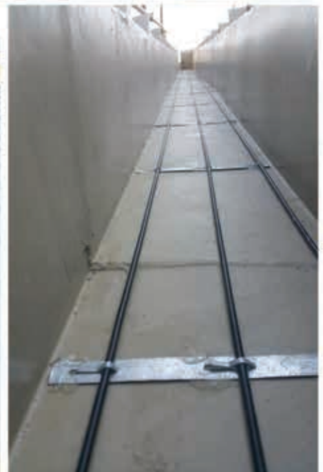
نصب سیستم گرمایشی الکتریکی در آبراه و مناطق برف گیر جهت جلوگیری از یخزدگی و انباشت برف (اجرا: زمستان ۹۵)
