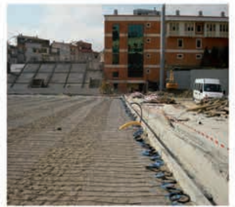
نصب سیستم ذوب برف در زیر چمن استادیوم فوتبال (اجرا: فوریه ۲۰۱۱)
