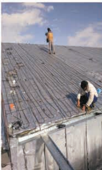
نصب سیستم گرمایشی بر روی بام و مناطق برف گیر جهت جلوگیری از یخ زدگی و انباشت برف (اجرا: زمستان ۹۵)
