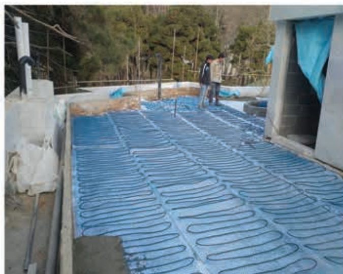
تجهیز رمپ خودرو، روف گاردن و مسیرهای تردد به سیستم ذوب برف و یخ الکتریکی هوشمند
