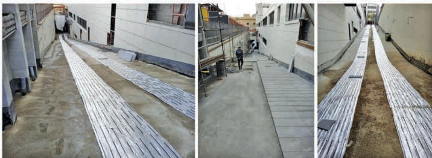
تجهیز رمپ خودرو به سیستم ذوب برف و یخ الکتریکی هوشمند
