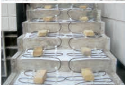
تجهیز کلیه بالکن‌ها، مسیرهای تردد و راه‌پله‌ها به سیستم ذوب برف و یخ الکتریکی هوشمند (اجرا: بهار ۹۰)
