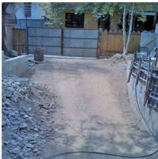
تجهیز مسیرهای تردد، رمپ خودرو و راه‌پله‌ها به سیستم ذوب برف و یخ هوشمند الکتریکی (اجرا: تابستان ۸۸)
