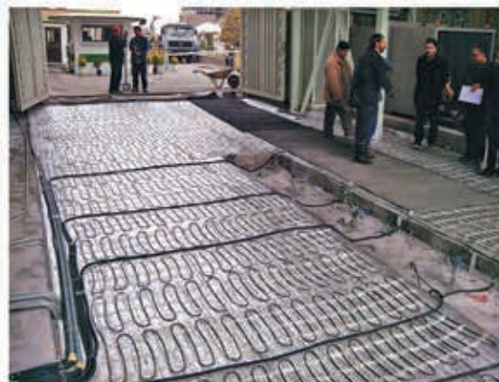
تجهیز رمپ عبور خودرو درب پارکینگ (بست حر عاملی) به سیستم گرمایش از کف الکتریکی هوشمند (اجرا: بهار ۹۳)
