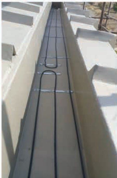
نصب سیستم گرمایشی الکتریکی در آبراه و مناطق برف گیر جهت جلوگیری از یخزدگی و انباشت برف (اجرا: زمستان ۹۵)
