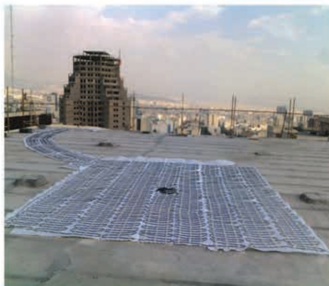
تجهیز پد هلی کوپتر به سیستم ذوب برف و یخ الکتریکی هوشمند (اجرا: تابستان ۸۹)
