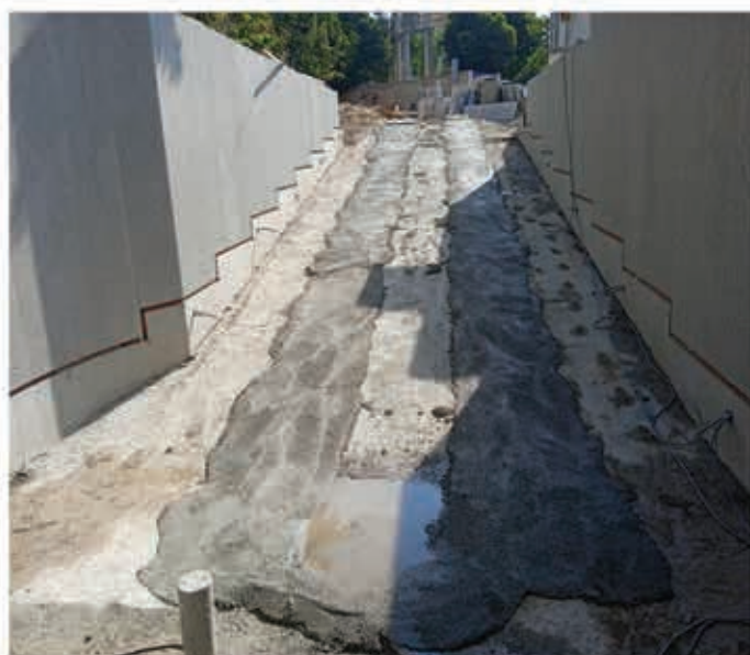
تجهیز مسیرهای تردد و رمپ خودرو به سیستم ذوب برف و یخ هوشمند الکتریکی
