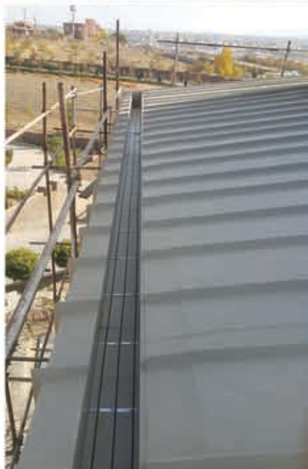
نصب سیستم گرمایشی الکتریکی در آبراه و مناطق برف گیر جهت جلوگیری از یخزدگی و انباشت برف (اجرا: زمستان ۹۵)
