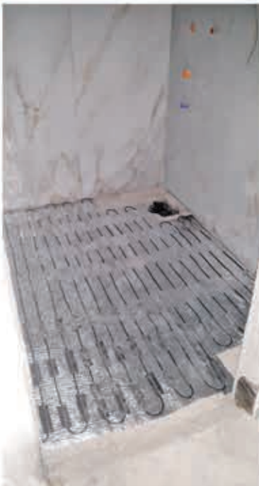
اجرای سیستم گرمایش از کف الکتریکی هوشمند در سرویس های بهداشتی و حمام
