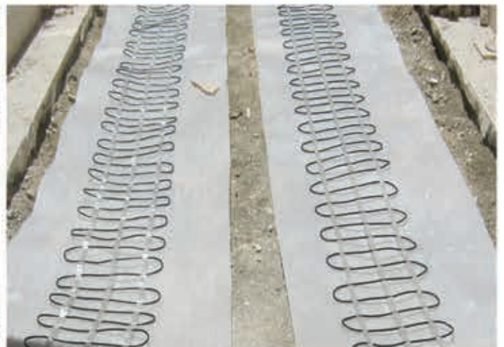
تجهیز رمپ خودرو به سیستم هوشمند ذوب برف و یخ الکتریکی (اجرا: بهار ۹۷)
