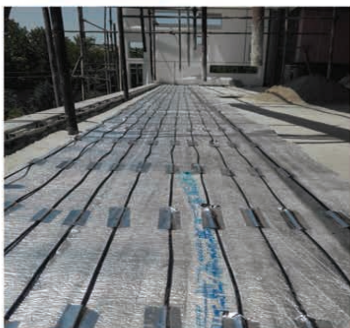
اجرای سیستم ذوب برف و یخ الکتریکی هوشمند در راه پله ها، مسیرهای تردد، رمپ خودرو و تراس
