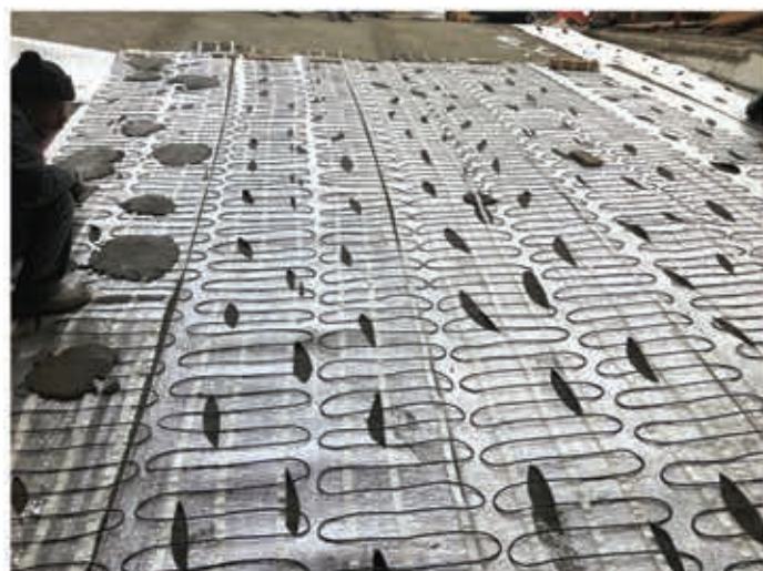
تجهیز مسیرهای تردد و رمپ خودرو به سیستم هوشمند ذوب برف و یخ الکتریکی
