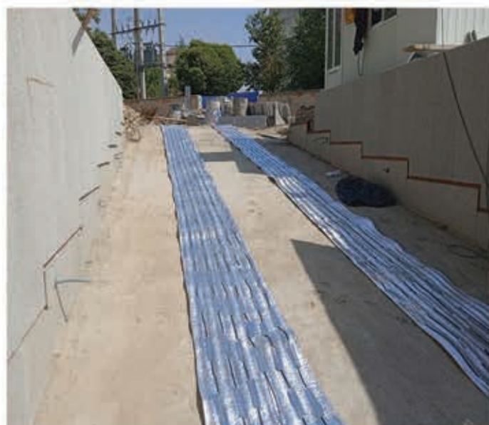
تجهیز مسیرهای تردد و رمپ خودرو به سیستم ذوب برف و یخ هوشمند الکتریکی
