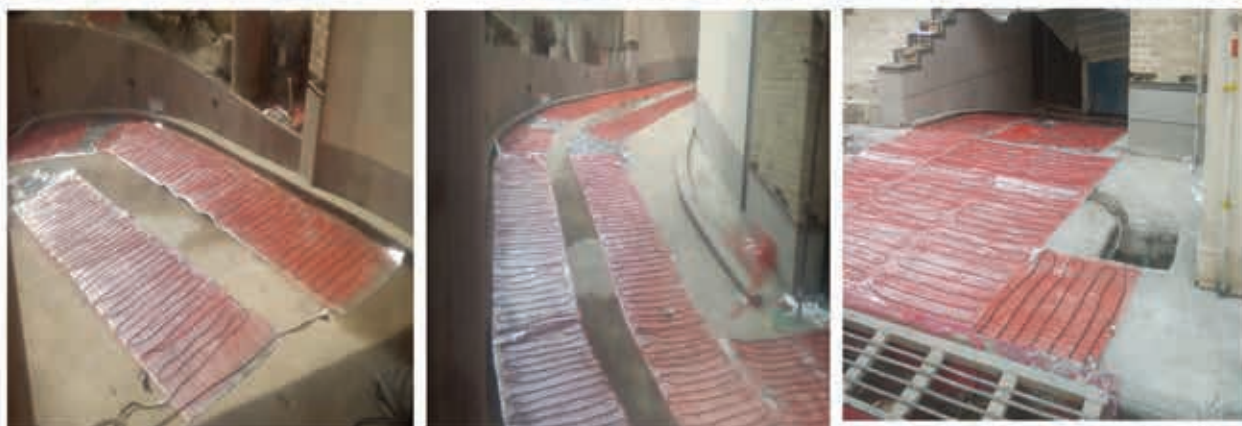
تجهیز رمپ خودرو و مسیرهای تردد به سیستم ذوب برف و یخ الکتریکی هوشمند
