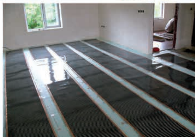
نصب سیستم گرمایش از کف الکتریکی مخصوص پارکت با استفاده از فیلم حرارتی (اجرا: پاییز ۸۹)
