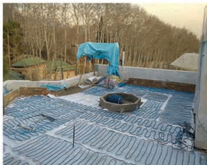
تجهیز رمپ خودرو، روف گاردن و مسیرهای تردد به سیستم ذوب برف و یخ الکتریکی هوشمند
