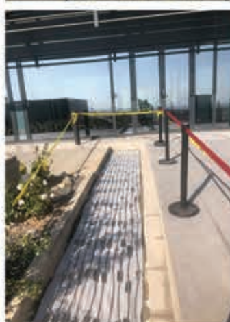
اجرای سیستم ذوب برف و یخ الکتریکی هوشمند در زیر آسفالت
