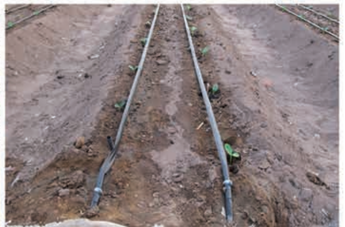
نصب کابل حرارتی جهت گرمایش ریشه گیاهان و سالن گلخانه (اجرا: پاییز ۹۰)
