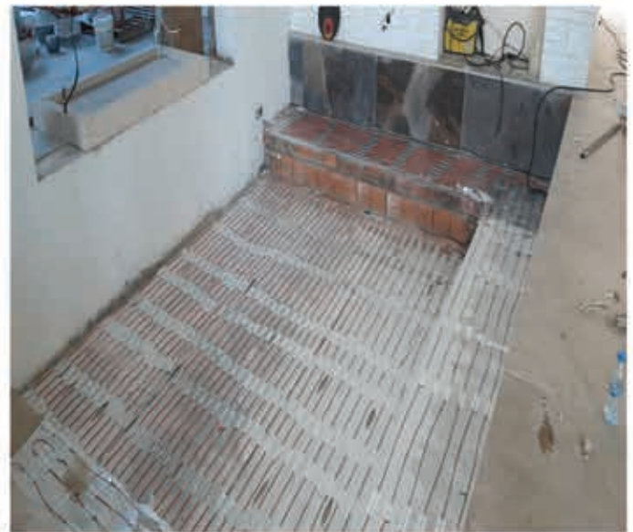
نصب سیستم گرمایش از کف الکتریکی هوشمند در سرویس ها، نشیمن و اتاق ها
