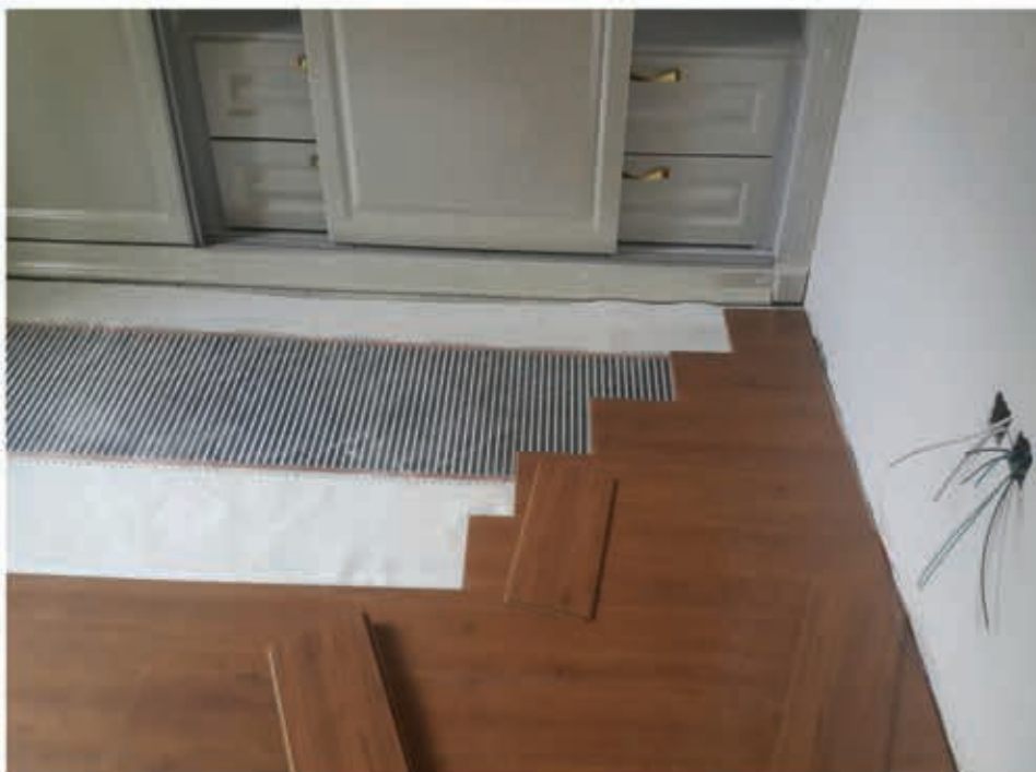
نصب فیلم‌های گرمایشی هوشمند الکتریکی مخصوص پارکت و لمینیت
