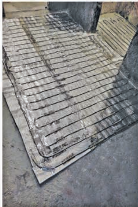
اجرای سیستم گرمایش از کف الکتریکی هوشمند در سرویس های بهداشتی و حمام
