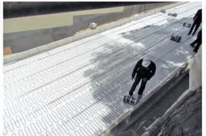
تجهیز رمپ خودرو به سیستم هوشمند ذوب برف و یخ الکتریکی (اجرا: بهار ۹۵)
