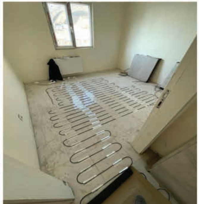
تجهیز سطوح داخلی ساختمان به سیستم گرمایش از کف الکتریکی هوشمند
