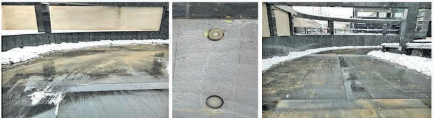
تجهیز رمپ خودرو به سیستم هوشمند ذوب برف و یخ الکتریکی (اجرا: پاییز ۹۵)
