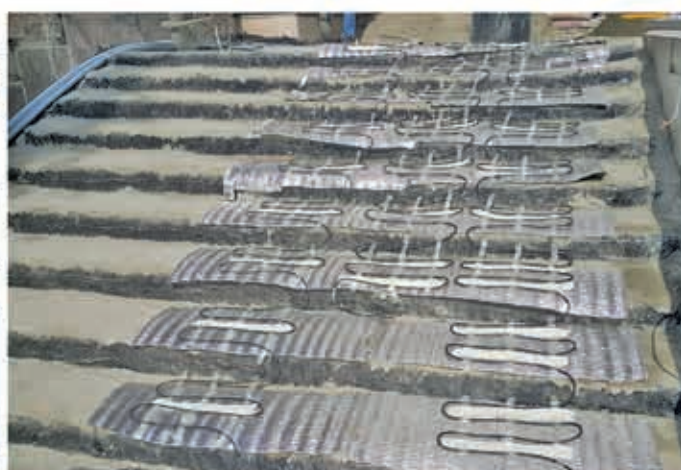
تجهیز مسیرهای تردد، راه‌پله‌ها و رمپ خودرو به سیستم هوشمند ذوب برف و یخ الکتریکی (اجرا: تابستان ۹۴)
