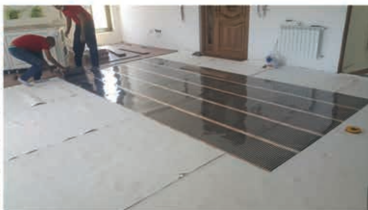
نصب فیلم‌های گرمایشی هوشمند الکتریکی مخصوص پارکت و لمینیت
