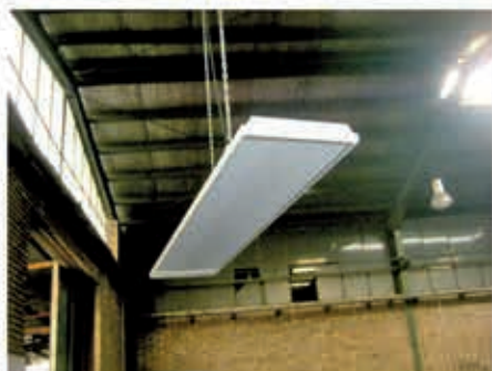
تجهیز فضای داخلی کارخانه به سیستم گرمایشی مادون قرمز (اجرا: اسفند ۸۹)
