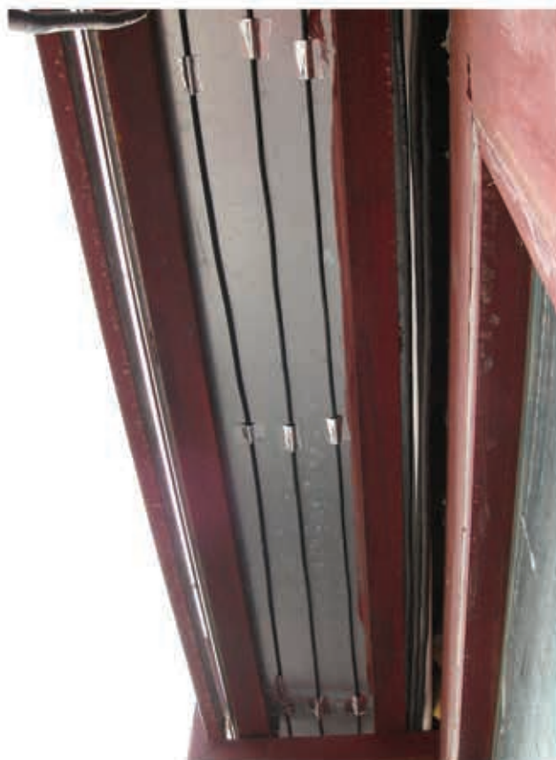
فاز ۱: تجهیز ناودان و آبراه‌ها به سیستم ذوب برف و یخ الکتریکی هوشمند (اجرا: بهار ۹۰)
