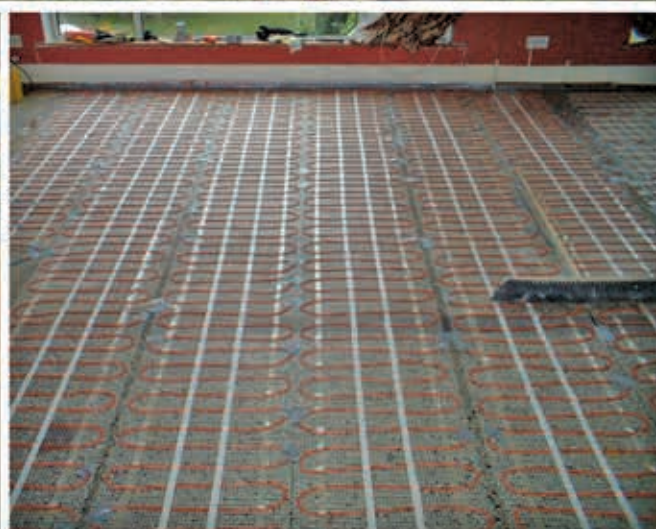
گرمایش از کف سطوح داخلی ساختمان (سرامیک) با استفاده از کابل های حرارتی
