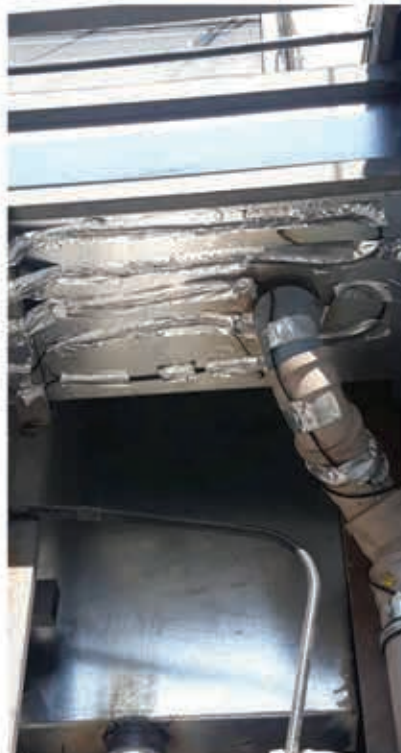
اجرای سیستم ذوب برف و یخ الکتریکی هوشمند آبراه و ناودان
