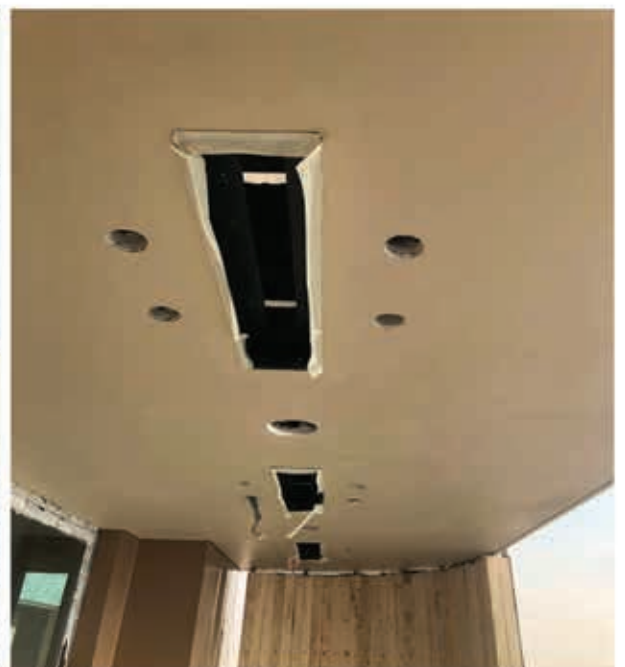
نصب بخاری گرمایشی تابشی مادون قرمز در سقف بالکن ها
