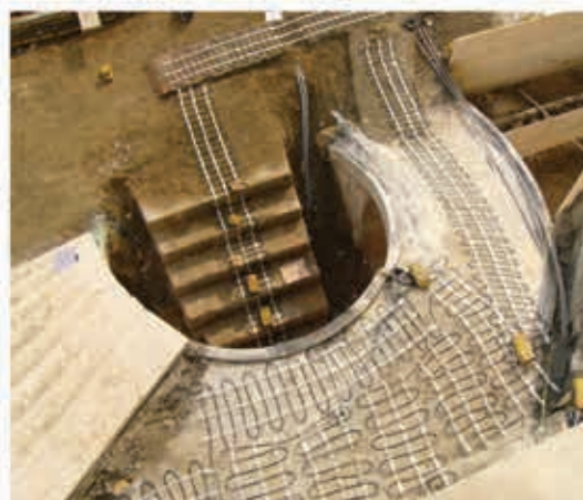
تجهیز محوطه‌های تردد و راه‌پله‌های عبوری به سیستم ذوب برف و یخ الکتریکی هوشمند (اجرا: بهار ۹۱)
