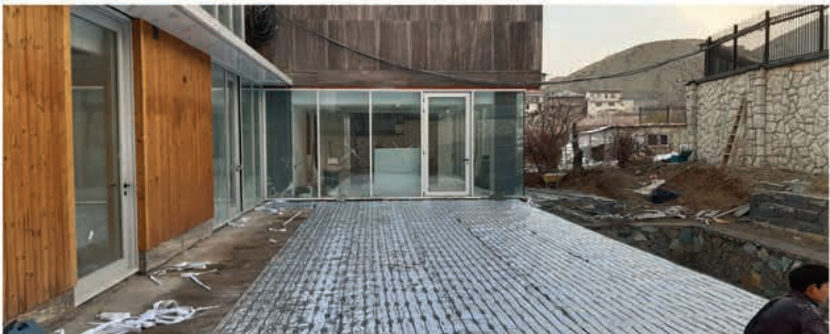
تجهيز رمپ خودرو، تراس و مسيرهاي تردد به سيستم ذوب برف و يخ الكتريكي هوشمند
