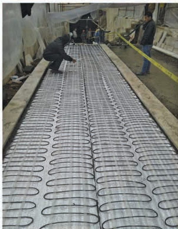
تجهیز مسیرهای تردد و رمپ خودرو به سیستم ذوب برف و یخ هوشمند الکتریکی
