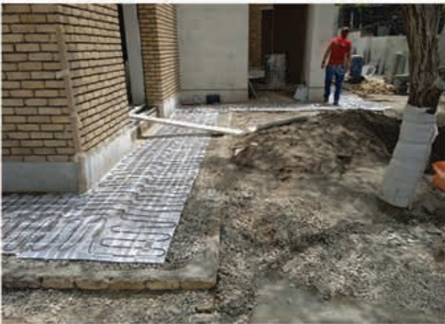
تجهیز مسیر تردد به سیستم هوشمند ذوب برف و یخ الکتریکی
