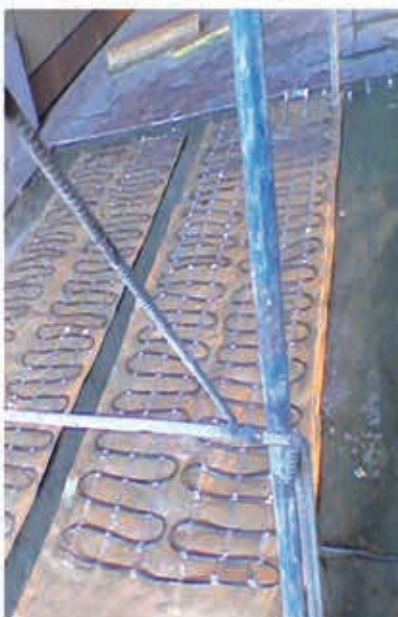
تجهیز مسیرهای ورودی و راهپله‌ها به سیستم ذوب برف و یخ الکتریکی هوشمند (اجرا: زمستان ۸۹)
