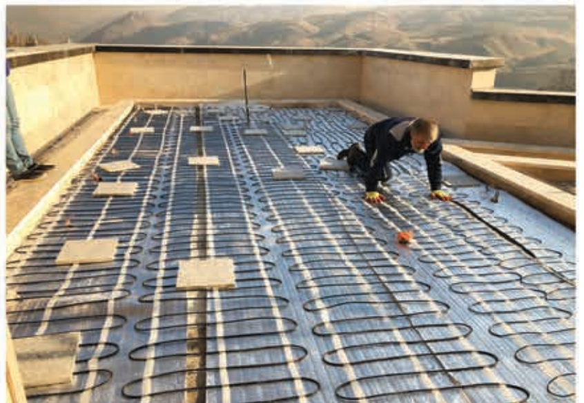
تجهيز محوطه بالکن به سيستم هوشمند ذوب برف و يخ الکتریکی (اجرا: زمستان ۹۶)
