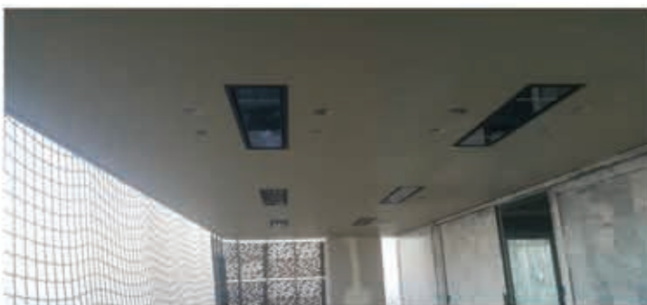
نصب بخاری گرمایشی تابشی مادون قرمز در سقف بالکن ها
