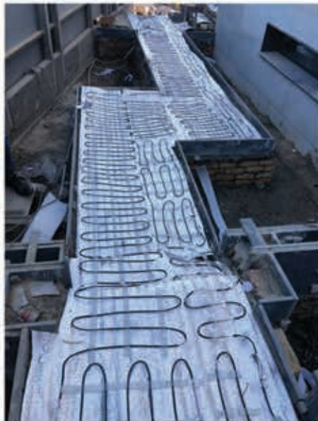
تجهیز رمپ خودرو، مسیرهای تردد و راه پله ها به سیستم ذوب برف و یخ الکتریکی هوشمند
