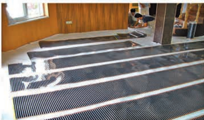
نصب سیستم گرمایش از کف الکتریکی مخصوص پارکت با استفاده از فیلم حرارتی (اجرا: پاییز ۸۹)
