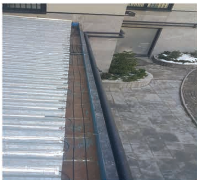
نصب سیستم گرمایشی بر روی بام و مناطق برف گیر جهت جلوگیری از یخ زدگی و انباشت برف
