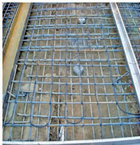
تجهیز پد هلی کوپتر به سیستم ذوب برف و یخ الکتریکی هوشمند (اجرا: بهار ۹۲)
