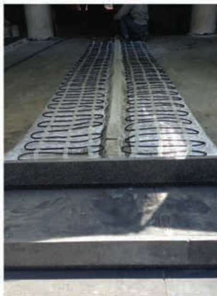
تجهیز رمپ خودرو، مسیرهای تردد و راه‌پله‌ها به سیستم ذوب برف و یخ الکتریکی هوشمند (اجرا: بهار ۹۷)
