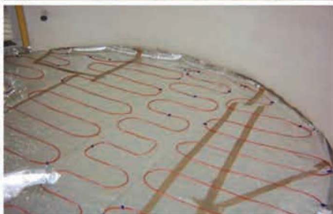
تجهیز محوطه اطراف استخر، اتاق‌ها و به سیستم گرمایش از کف الکتریکی هوشمند (اجرا: بهار ۹۷)
