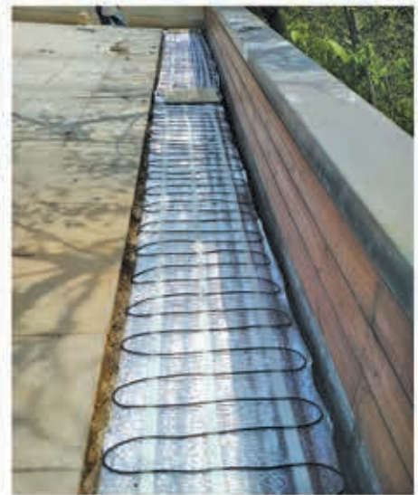
- تجهیز محوطه بالکن‌ها به سیستم هوشمند ذوب برف و یخ الکتریکی - استفاده از کابل حرارتی داخل آبراه با هدف ذوب برف و یخ (اجرا: بهار ۹۷)
