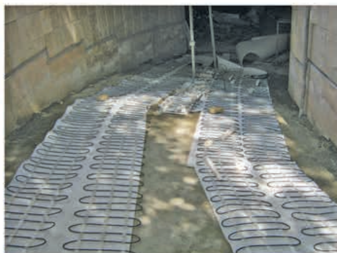
تجهیز رمپ خودرو به سیستم ذوب برف و یخ الکتریکی هوشمند (اجرا: تابستان ۹۵)
