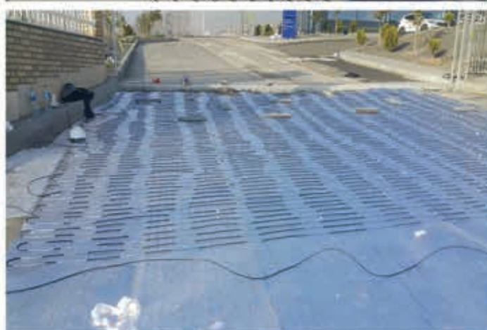
اجرای سیستم ذوب برف و یخ الکتریکی هوشمند در زیر آسفالت
