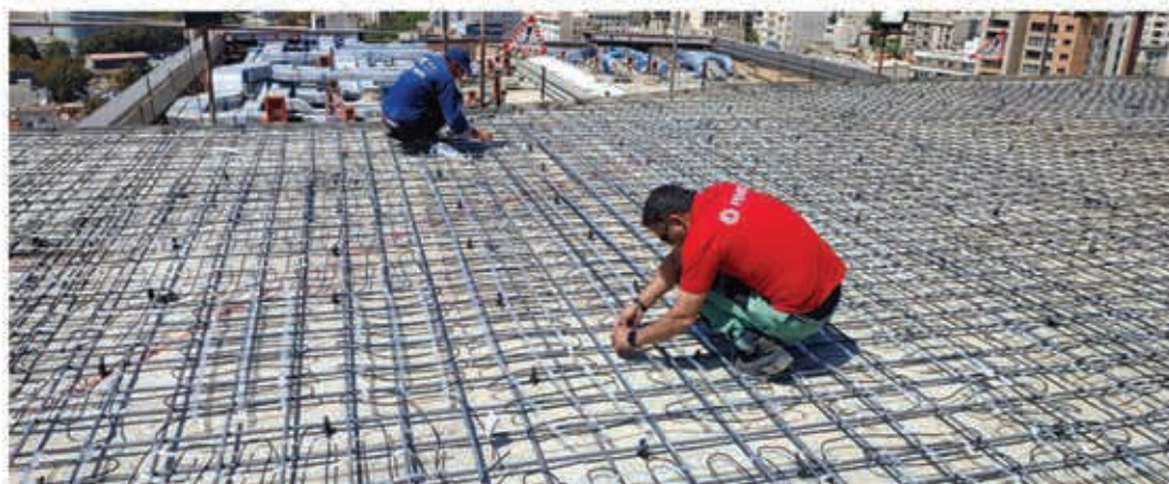
تجهیز هلی پد به سیستم ذوب برف و یخ الکتریکی هوشمند
