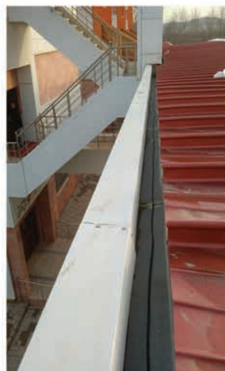
اجرای سیستم ذوب برف و یخ الکتریکی هوشمند آبراه و ناودان
