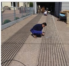
نیاوران - خیابان یاسر تجهیز رمپ خودرو به سیستم گرمایش از کف برقی هوشمند
