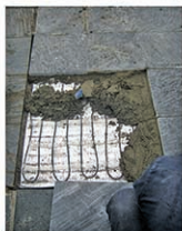
تجهیز صحن مطهر رضوی به سیستم گرمایش از کف الکتریکی هوشمند
