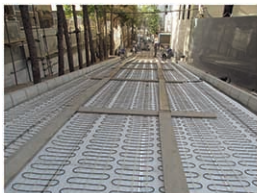
نصب سیستم ذوب برف و یخ الکتریکی رمپ خودرو زعفرانیه (مقدس اردبیلی)
