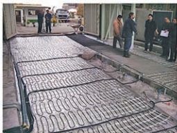
تجهیز رمپ عبور خودرو درب پارکینگ ( بست حر عاملی ) به سیستم گرمایش از کف الکتریکی هوشمند
