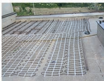
نصب سیستم ذوب برف و یخ در روف گاردن درپند سر - مجتمع مسکونی حافظ
