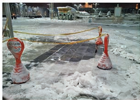
تجهیز رمپ عبور خودرو درب پارکینگ ( بست حر عاملی ) به سیستم گرمایش از کف الکتریکی هوشمند
