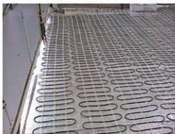
تجهیز رمپ عبور خودرو درب پارکینگ ( بست حر عاملی ) به سیستم گرمایش از کف الکتریکی هوشمند
