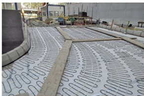
نصب سیستم ذوب برف و یخ در روف گاردن درپند سر - مجتمع مسکونی حافظ
