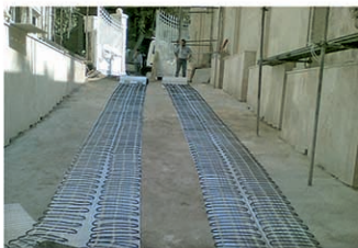
نیاوران - خیابان یاسر تجهیز رمپ خودرو به سیستم گرمایش از کف برقی هوشمند
