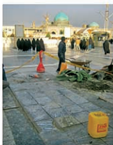
تجهیز رمپ عبور خودرو درب پارکینگ ( بست حر عاملی ) به سیستم گرمایش از کف الکتریکی هوشمند
